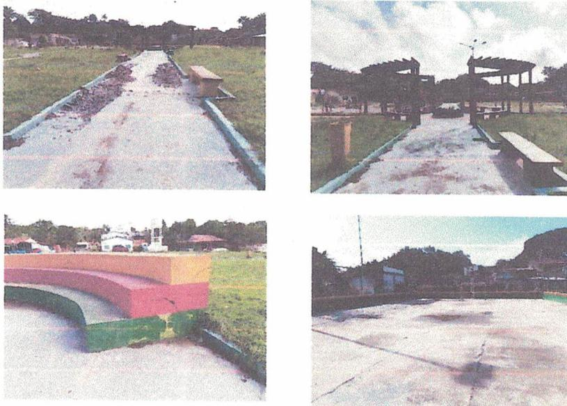
Imagem 2 – Deterioração do espaço público, com pisos quebrados, afundados, arquibancada rachada, brinquedos e aparelhos sem manutenção.
